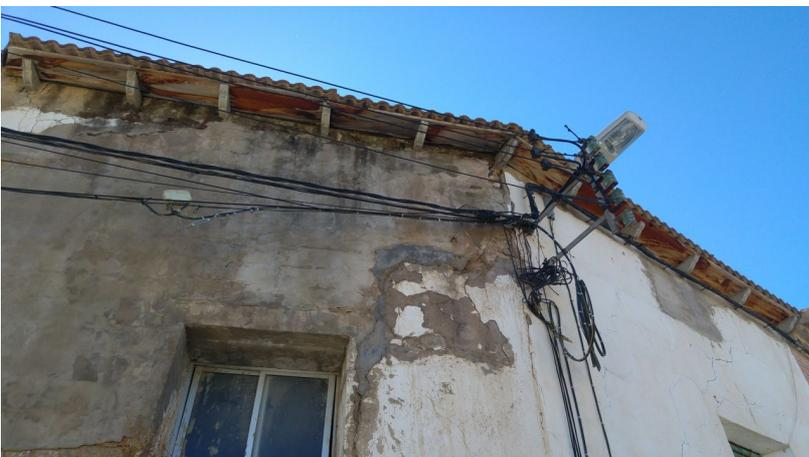
En la fachada a la c/ Las Cuevas se aprecia una grieta con testigos rotos que evidencian que el desplome se sigue produciendo lentamente.
