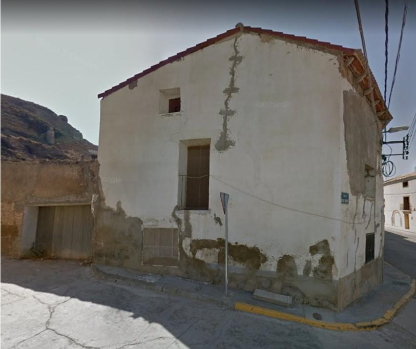
Adosado a la vivienda hay 2 construcciones muy deterioradas de tan solo planta baja. Resalta el buen estado de la cubierta que según me comentan se rehabilito hace pocos años.
