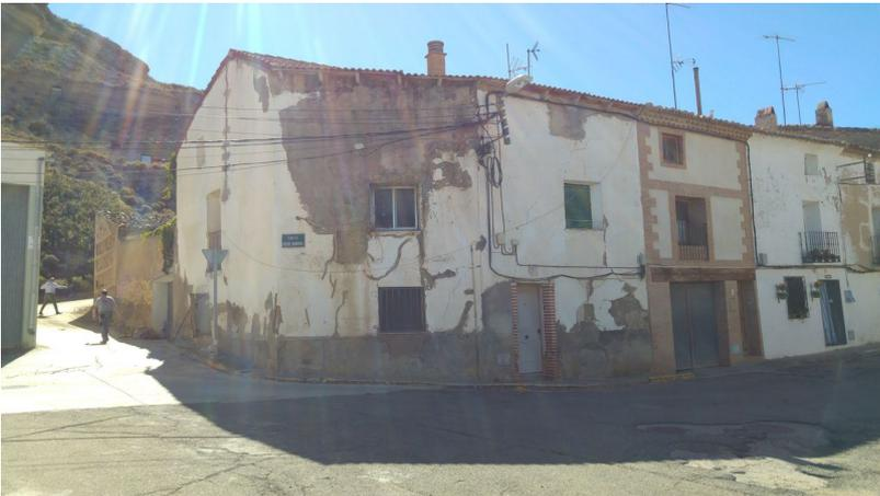
Se aprecia el desplome de la fachada a la c/ Felix Burriel y que la humedad ha ido desconchando el revestimiento desde el alero hasta la planta baja.
